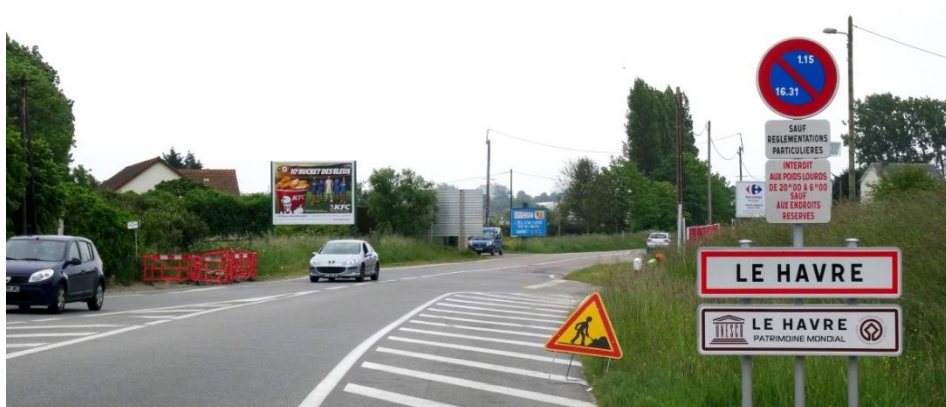
Entrée de ville Nord-Ouest, D940. 06/2016. AURH
